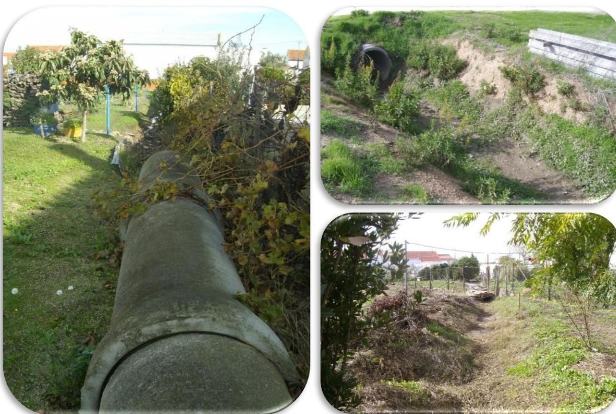
FIGURA 26 - Foros de Vale de Figueira: a ocupação da margem, muitas vezes com construções ou outras estruturas, e o entubamento, ainda que parcial, de algumas das linhas de água que ocorrem na área urbana da freguesia constituem problemas de difícil resolução. Nestas situações, é também notória a inexistência da galeria ripícola.
