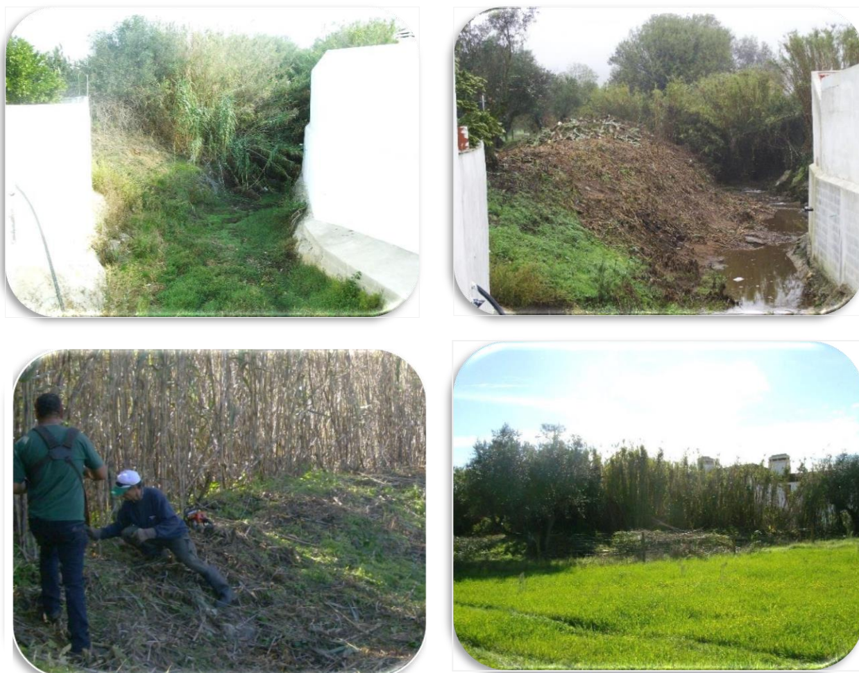
FIGURA 25 – Ribeira do Escoural/troço urbano: trabalhos de remoção de invasoras realizados pelos serviços municipais no âmbito do projeto GAPS (2003-2008)
