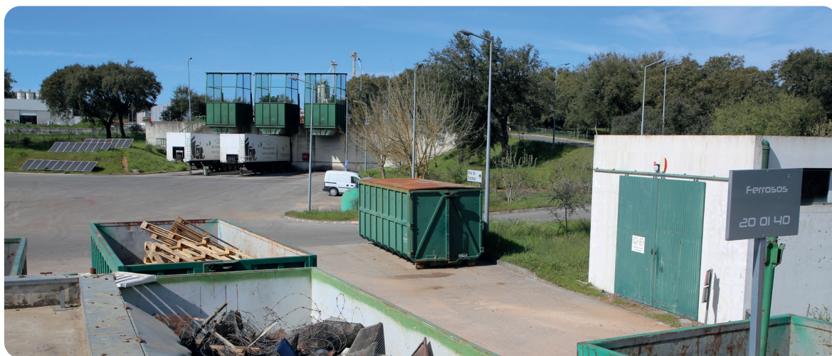
Estação de Transferência e Ecocentro de Montemor-o-Novo
