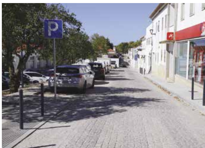
Requalificação da Rua Comandante Fragoso
