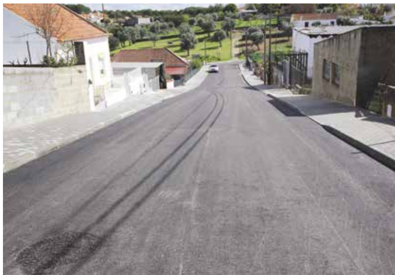
Arruamentos e outras infraestruturas em Cíborro
