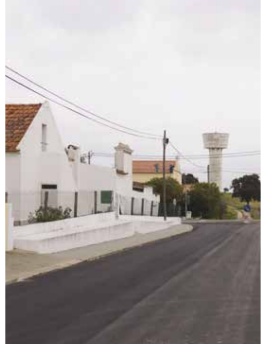
Pavimentação na Rua Caminhos do Futuro, Foros de Vale de Figueira
