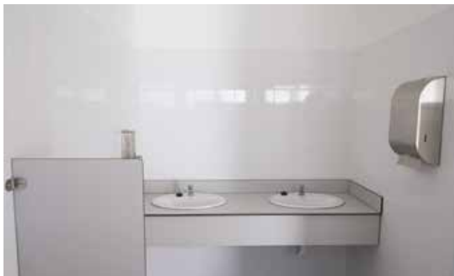
Remodelação de Sanitários Públicos no Largo do Povo em Cíborro
