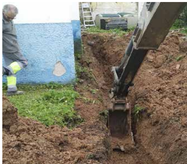
Renovação de Condução de Rede de Água em Lavre
