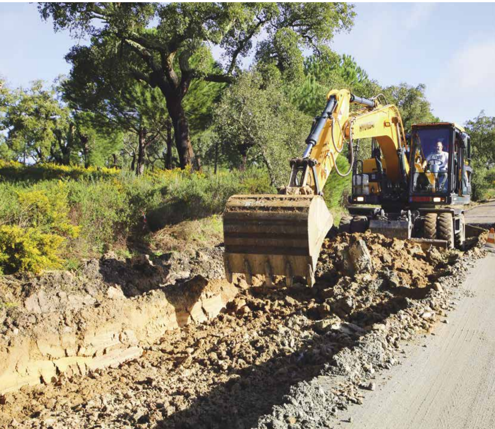
Beneficiação do troço da Estrada Municipal EM 507 (Lavre - Cíborro)
