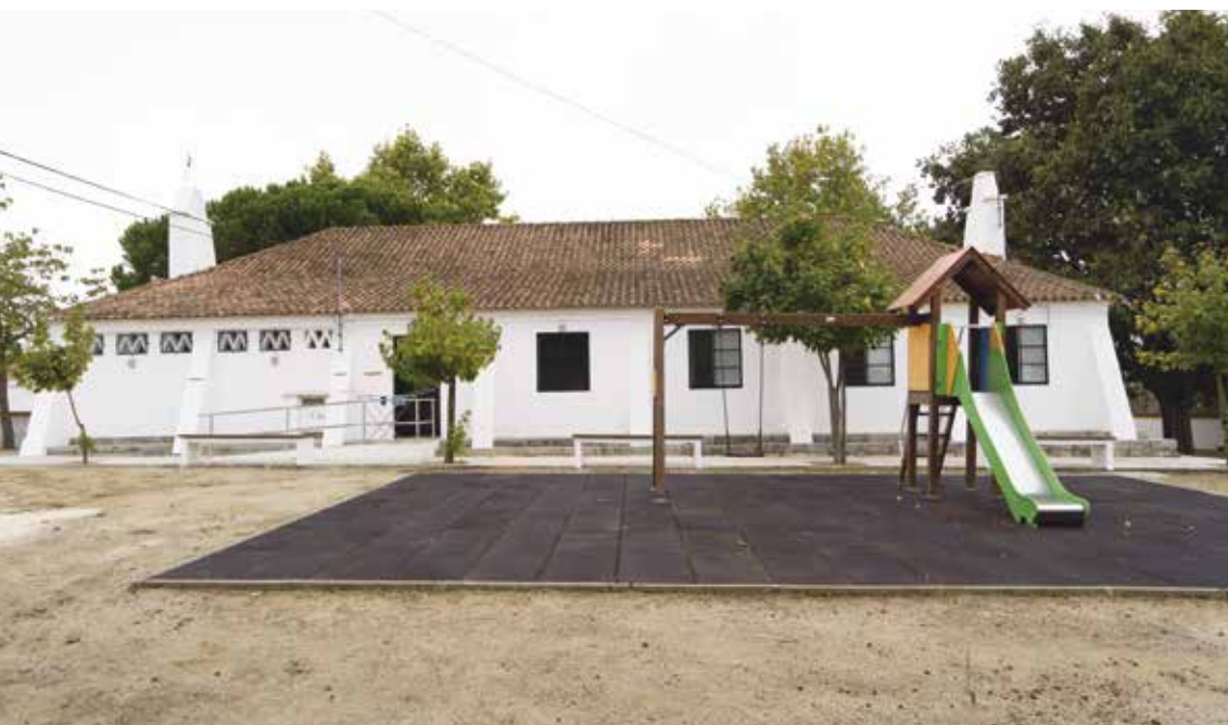
Obras na antiga EB n.º 3 em Montemor-o-Novo, para instalação provisória do Jardim de Infância nº1
