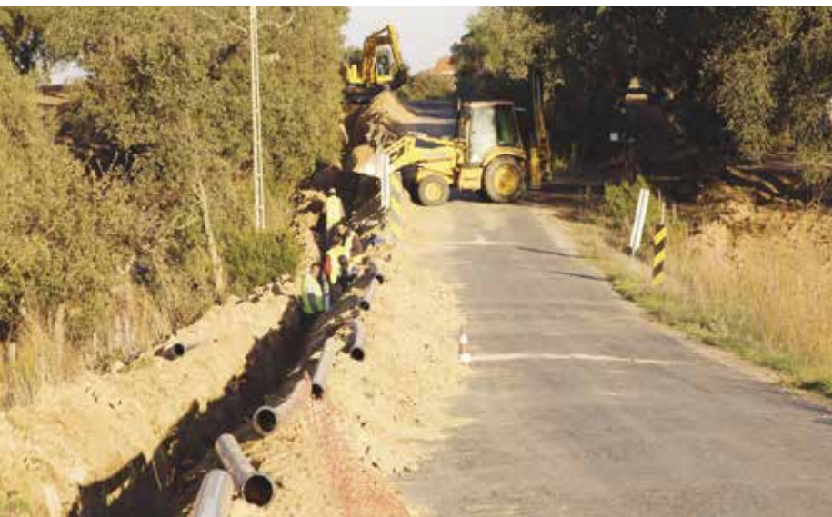
Renovação de Condução de Rede de Água em Cíborro
