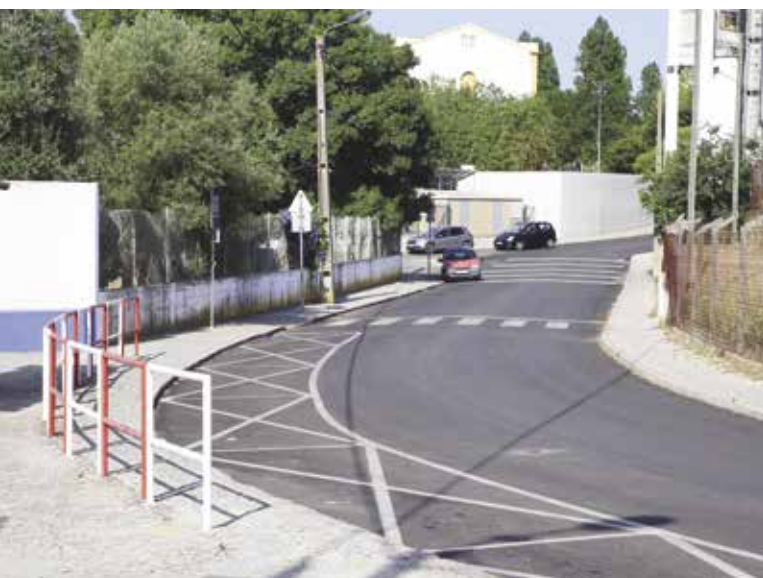
Repavimentação de ruas na Cidade de Montemor-o-Novo
