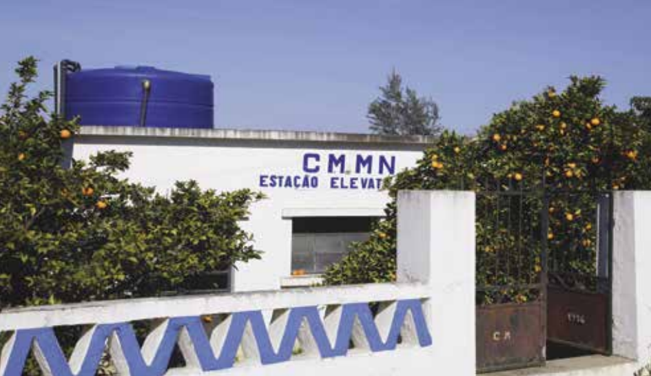
Estação Elevatória de Águas em Lavre
