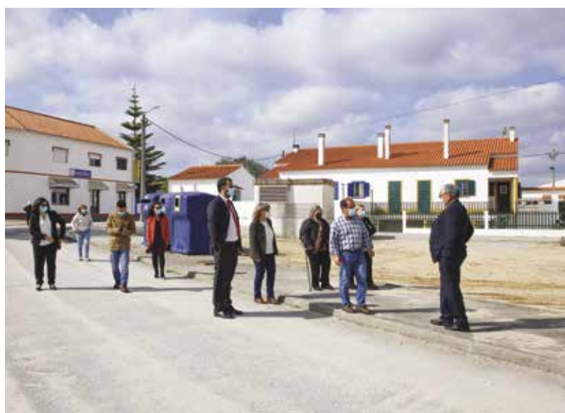
Visita dos eleitos - Reparação de pavimento junto ao Posto Médico em Cortiçadas de Lavre
