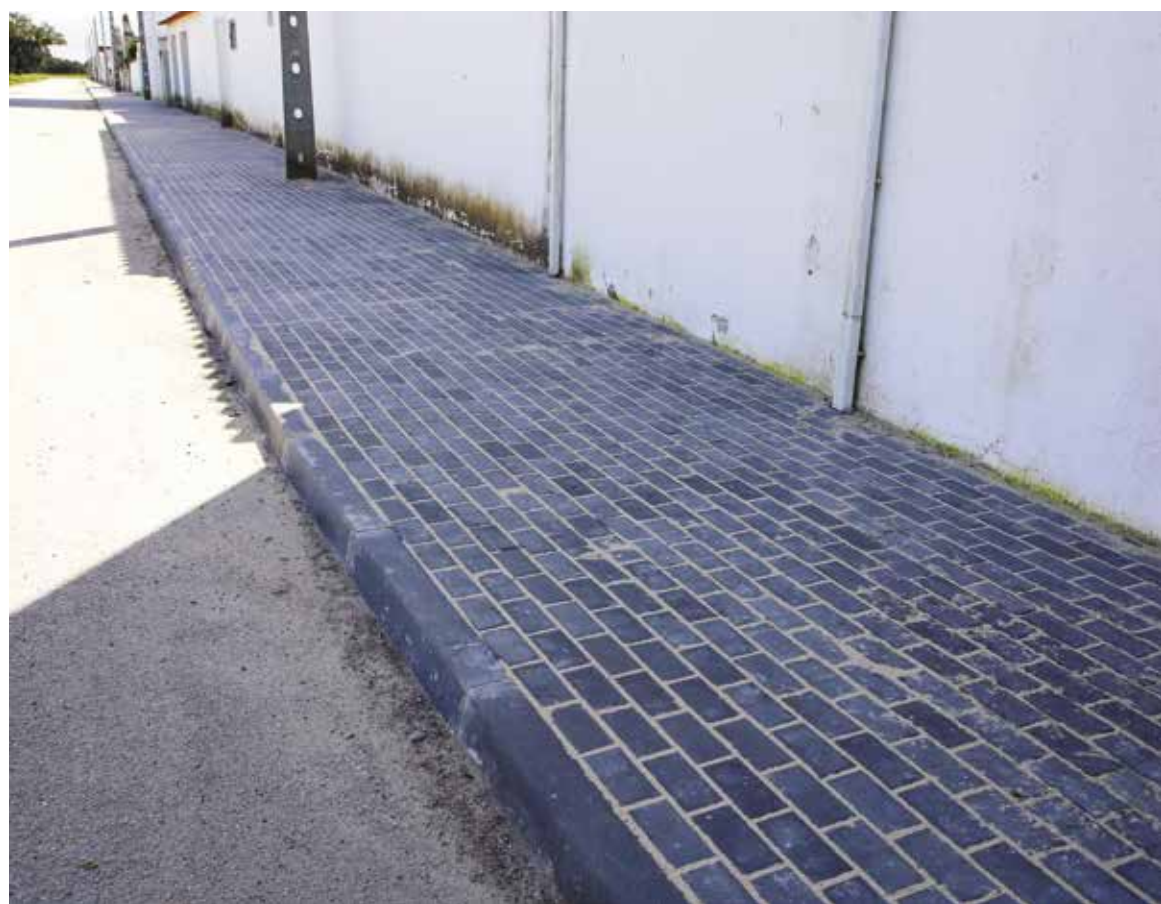
Construção de passeios em Casa Branca
