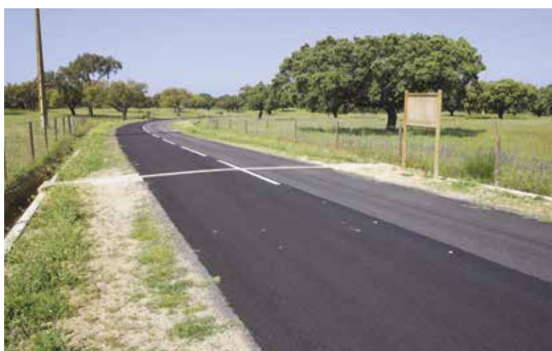
Beneficiação da Estrada Municipal 535 (Escoural-S.Cristóvão)
