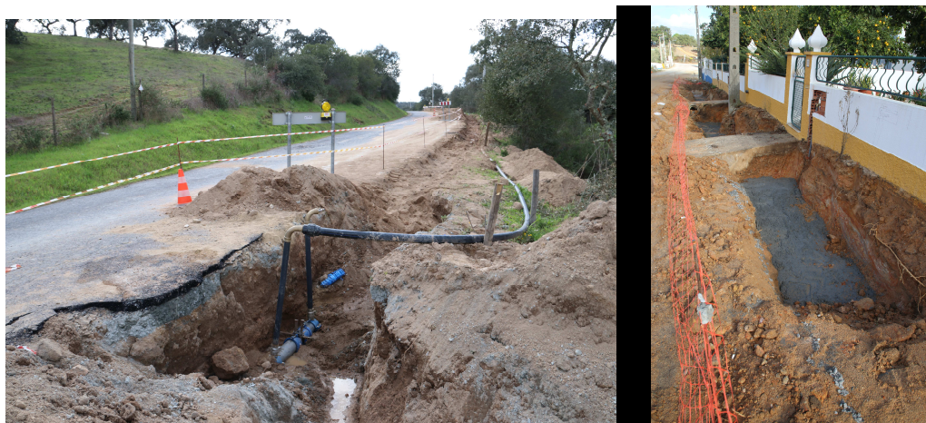
Remodelação da Conduta de Abastecimento de Água no Cíborro e em Cortiçadas de Lavre
