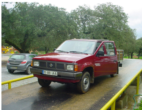
Figura 6.15 – A plataforma de pesagem não apresentava barras laterais de segurança. No sentido de evitar eventuais acidentes durante a pesagem, foram construídas e instaladas barras de segurança.
