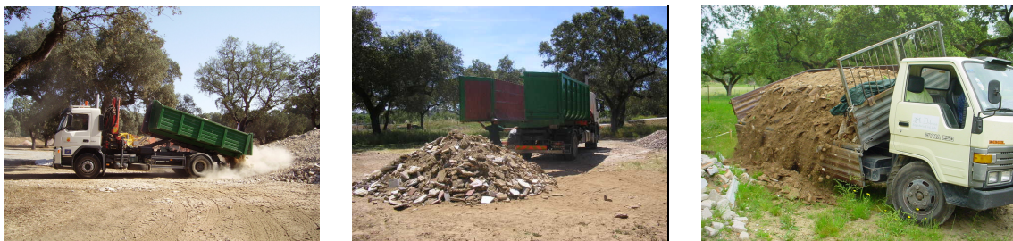
Figura 4.2 – Descarga dos resíduos na zona de armazenamento.
