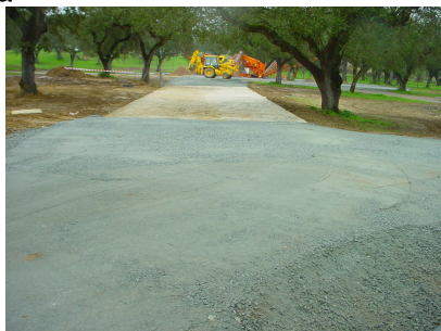
e) compactação das zonas de armazenamento e circulação
