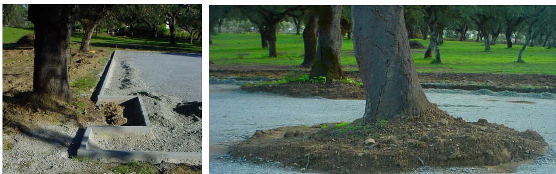
Figura 2.2 – Alguns exemplos de medidas de protecção às árvores existentes, durante a execução da obra de instalação da Unidade Piloto
