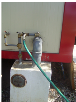
Figura 6.14 – No sentido de remover lamas e terras que se acumulavam na plataforma de pesagem, foi instalado um ponto de água junto à mesma.
