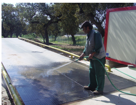
Figura 6.14 – No sentido de remover lamas e terras que se acumulavam na plataforma de pesagem, foi instalado um ponto de água junto à mesma.
