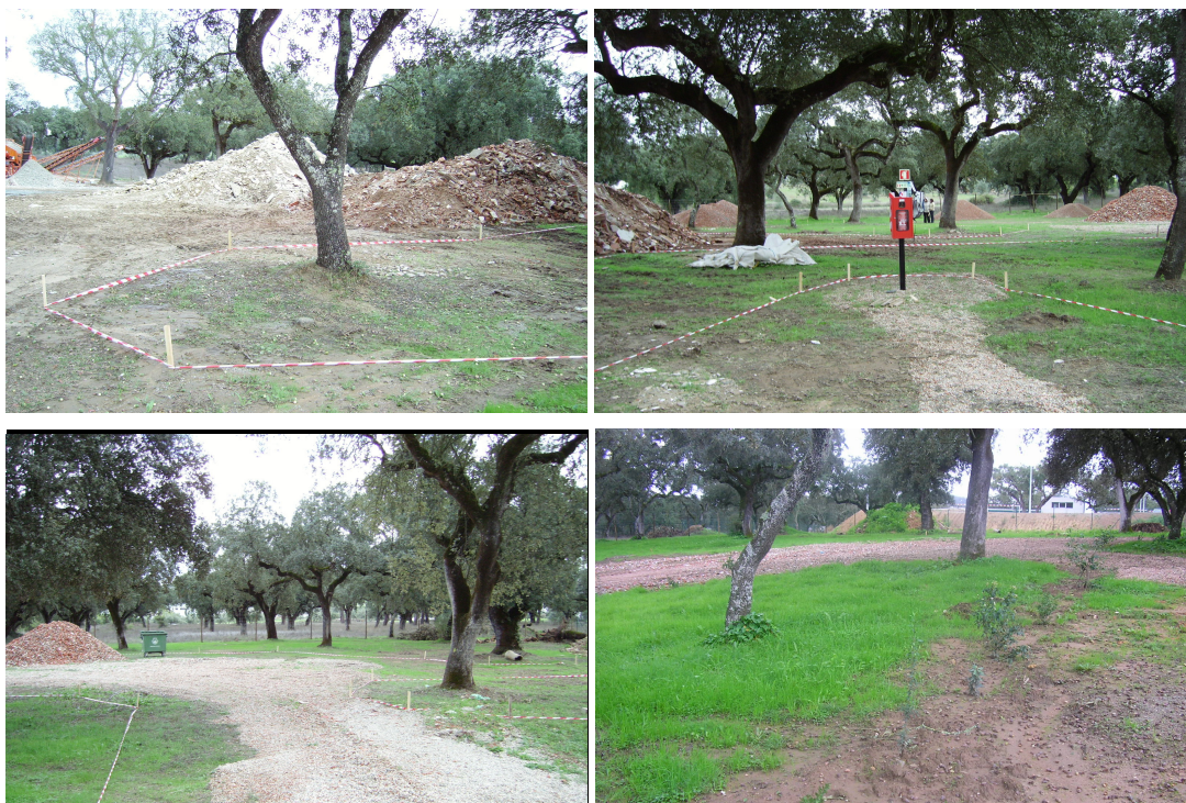
Figura 6.17 – Definição de zonas de protecção às árvores existentes, através de fitas de sinalização e plantação de arbustos.
