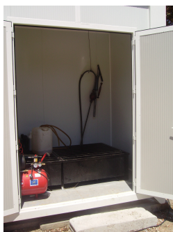
Figura 6.21 – Bacias de retenção em metal, construídas pelos serviços da CMMN, de forma a promover o correcto armazenamento de combustíveis e óleos usados na Unidade Piloto. Estas bacias encontram-se num compartimento separado na estrutura coberta instalada junto à plataforma de reciclagem.
