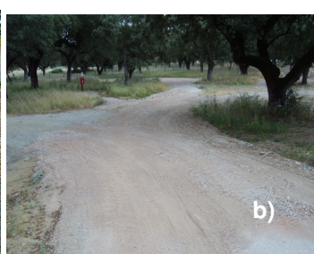
Figura 6.16 – Aspecto geral das zonas de circulação internas, após aplicação de camada de agregados reciclados (a; b) Aplicação de agregados reciclados na zona de armazenamento dos RCD, com o objectivo de melhorar as condições de armazenamento (c).
