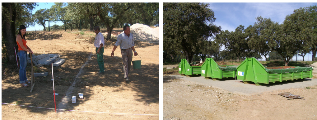
Figura 5.19 – Pavimentação da zona de armazenamento temporário de resíduos
