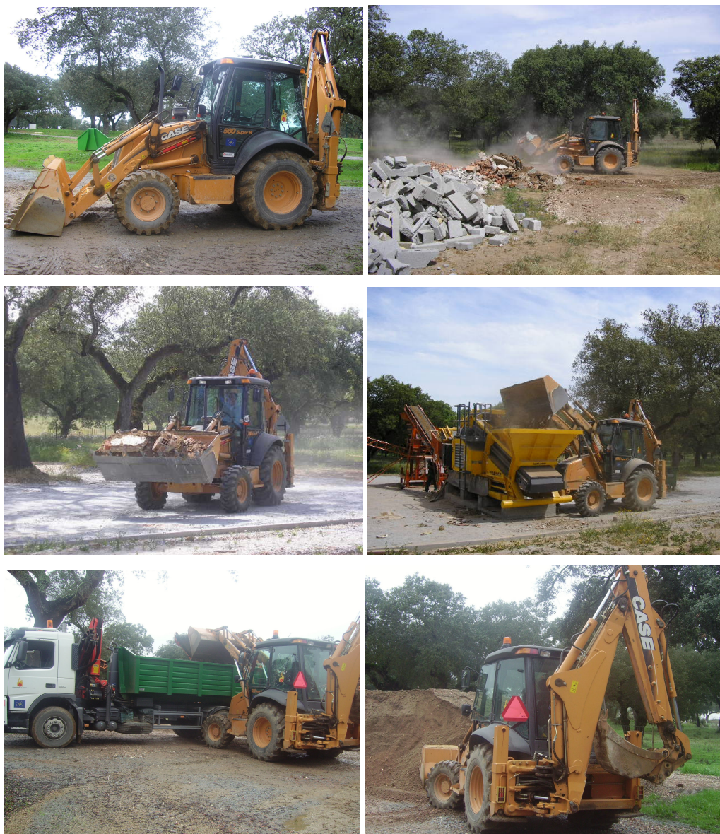
Figura 3.13 – Serviços assegurados pela retro-escavadora (exemplos)
