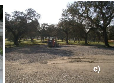
Figura 6.16 – Aspecto geral das zonas de circulação internas, após aplicação de camada de agregados reciclados (a; b) Aplicação de agregados reciclados na zona de armazenamento dos RCD, com o objectivo de melhorar as condições de armazenamento (c).
