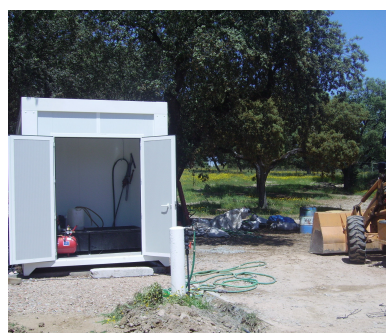
Figura 6.21 – Bacias de retenção em metal, construídas pelos serviços da CMMN, de forma a promover o correcto armazenamento de combustíveis e óleos usados na Unidade Piloto. Estas bacias encontram-se num compartimento separado na estrutura coberta instalada junto à plataforma de reciclagem.
