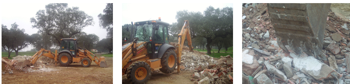
Figura 4.4 - Fracturação de alguns resíduos antes da sua britagem, de forma a garantir uma dimensão adequada
