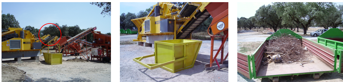
Figura 4.6 – Separador electromagnético e recolha de fracções metálicas existentes no RCD reciclados
