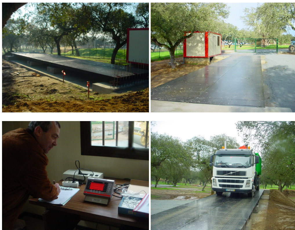
Figura 3.12 – Trabalhos de instalação da báscula e aspecto final depois da montagem
