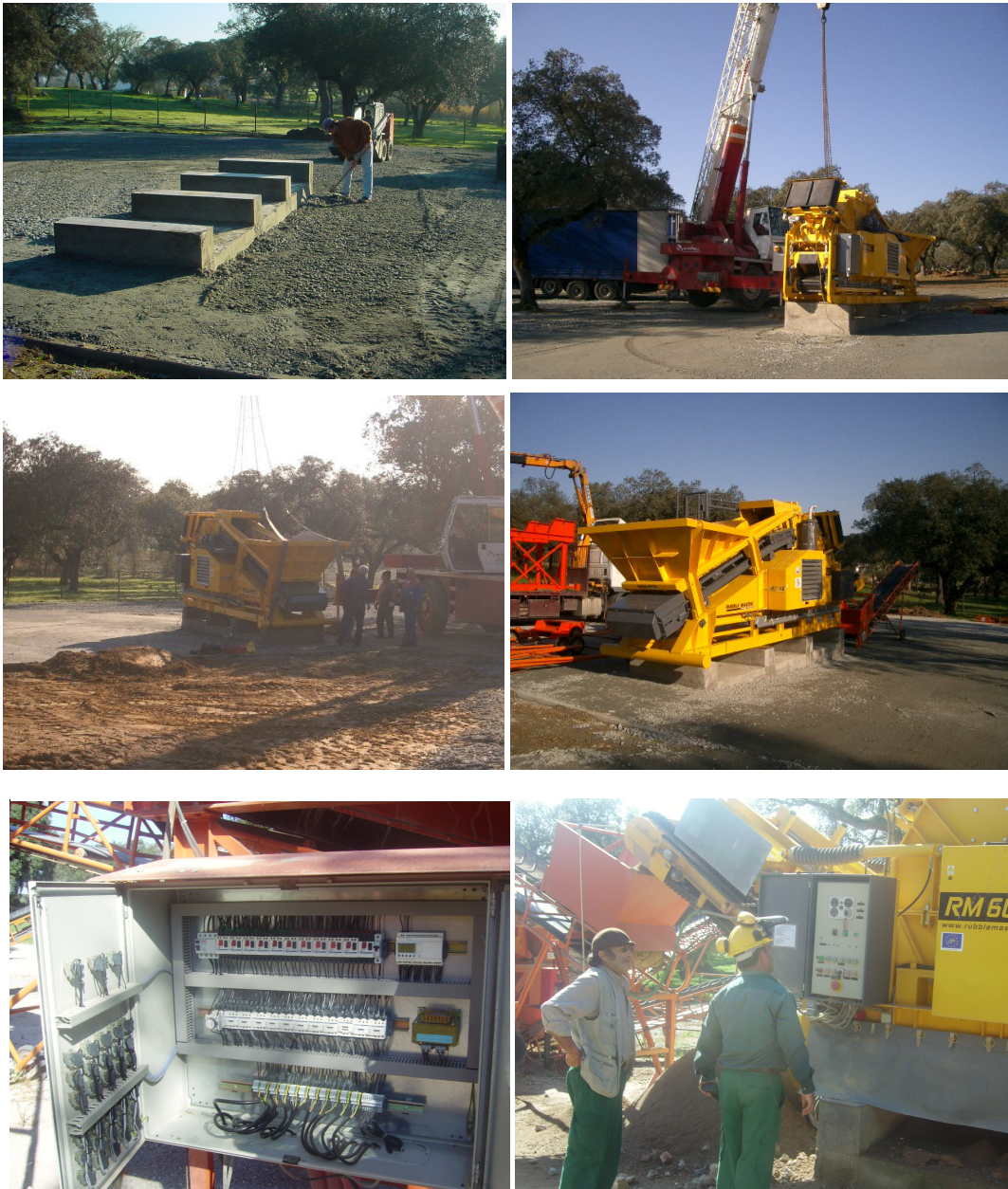
Figura 3.10 - Aspectos gerais da montagem do britador
