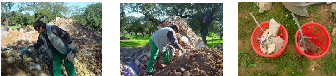
Figura 4.19 – Triagem manual dos materiais não inertes de maiores dimensões, previamente à sua reciclagem.
