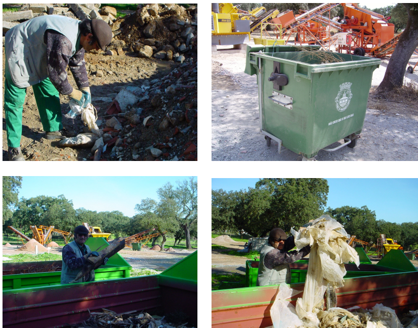
Figura 4.3 – Triagem manual e armazenamento de fracções não inertes.
