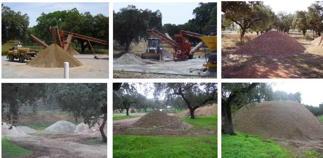
Figura 4.10 – Transporte e armazenamento dos agregados reciclados na Zona de Armazenamento
