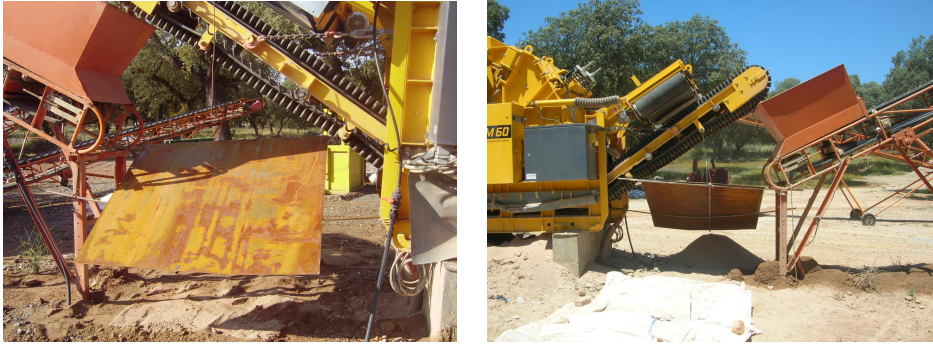
Figura 6.3 – Instalação da estrutura metálica para evitar que os finos caiam dentro do recipiente de recolha e armazenamento dos materiais ferrosos.
