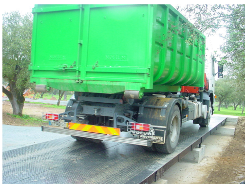
Figura 6.15 – A plataforma de pesagem não apresentava barras laterais de segurança. No sentido de evitar eventuais acidentes durante a pesagem, foram construídas e instaladas barras de segurança.
