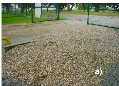
Figura 6.16 – Aspecto geral das zonas de circulação internas, após aplicação de camada de agregados reciclados (a; b) Aplicação de agregados reciclados na zona de armazenamento dos RCD, com o objectivo de melhorar as condições de armazenamento (c).
