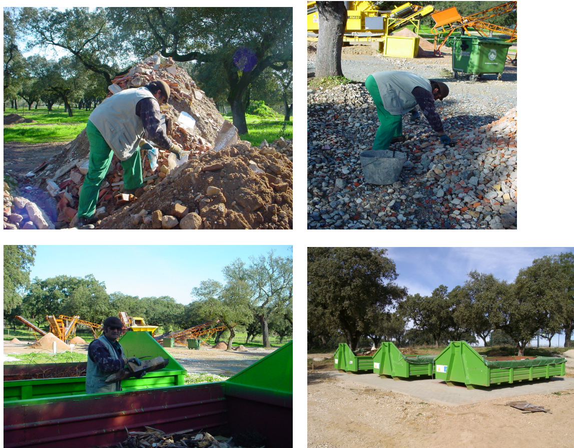
Figura 4.8 – Triagem manual de resíduos não inertes
