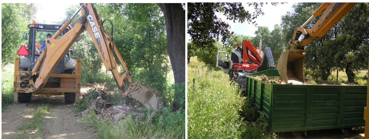
Figura 3.10 – Limpeza de depósitos ilegais de RCD
