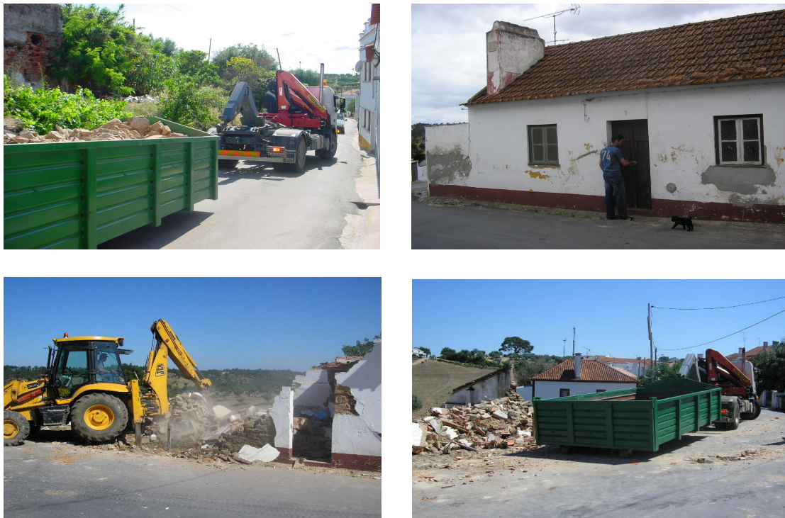
Figura 3.5 – Acompanhamento e recolha de RCD em obras de demolição
