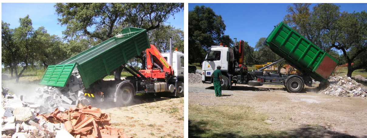
Figura 3.9 – Descarga na unidade piloto de reciclagem com contentor metálico proveniente de recolhas em obras
