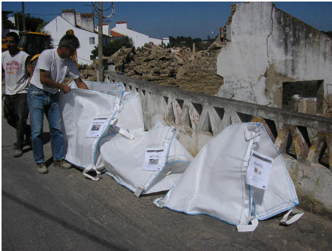
Figura 3.1 – Separação dos RCD não inertes no local da obra (papel, metal e plástico)
