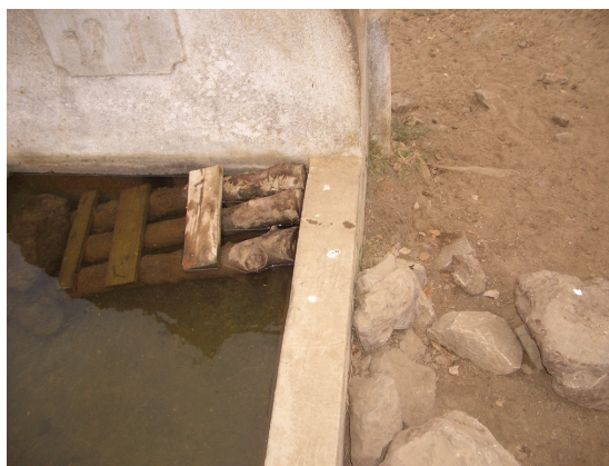
Figura 75 e 76 – Detalhes da adaptação, com materiais naturais, dos bebedouros de gado ao acesso da fauna silvestre.
